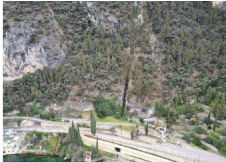
Il tratto La strada Gardesana occidentale all'altezza di Limone
